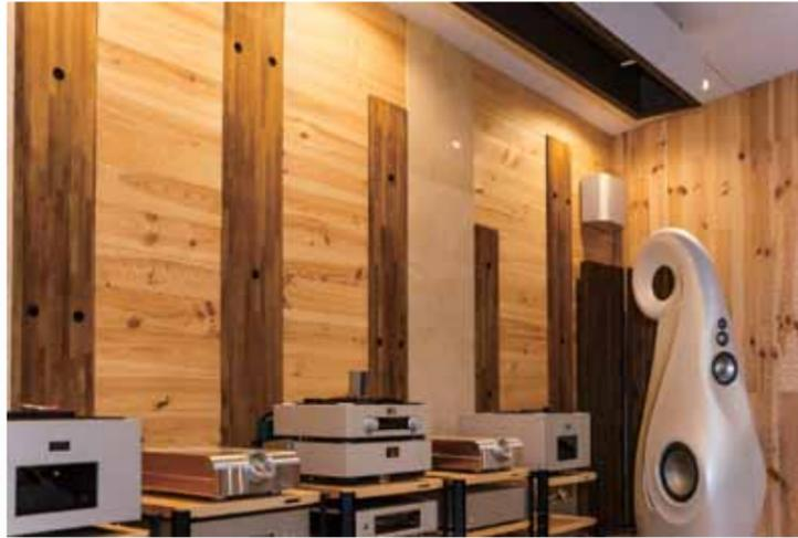
正面の壁には楯の集成材による7本の音柱を設置。この柱は奥行きが20cm近くあり、コンクリートアンカーで固定されている。これら柱の間にはフランスパイン材と大理石が配置され、すべてがカイザー寸法で構成されている
