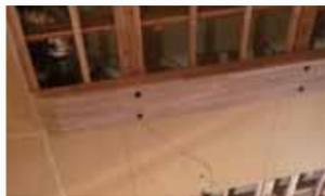
天井柱の工事の様子。音柱はコンクリートにアンカーで直接固定されている
