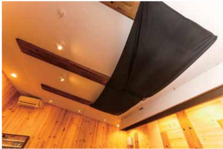
天井は日本家屋の蔵に使われた漆喰を使用。天井は傾斜があり、その傾斜を利用して奥行き10cm近い楯の集積材の柱を3本をコンクリートからアンカーで固定している
