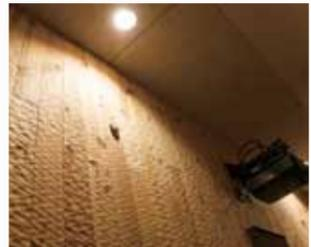
左右と後方の壁はフランスパイン材を特殊に加工したものを採用。これらもすべてカイザー理論で音の走る方向に揃えられている
